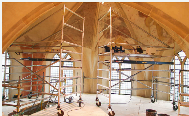
DE RESTAURATIESTEIGERS ZIJN IN KERSTIJD WEG
