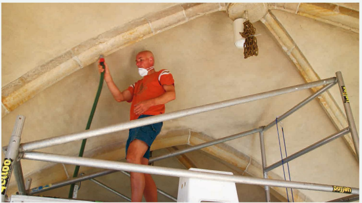
GRONDIG SCHOONMAAKWERK BOVENIN EEN GEWELF
